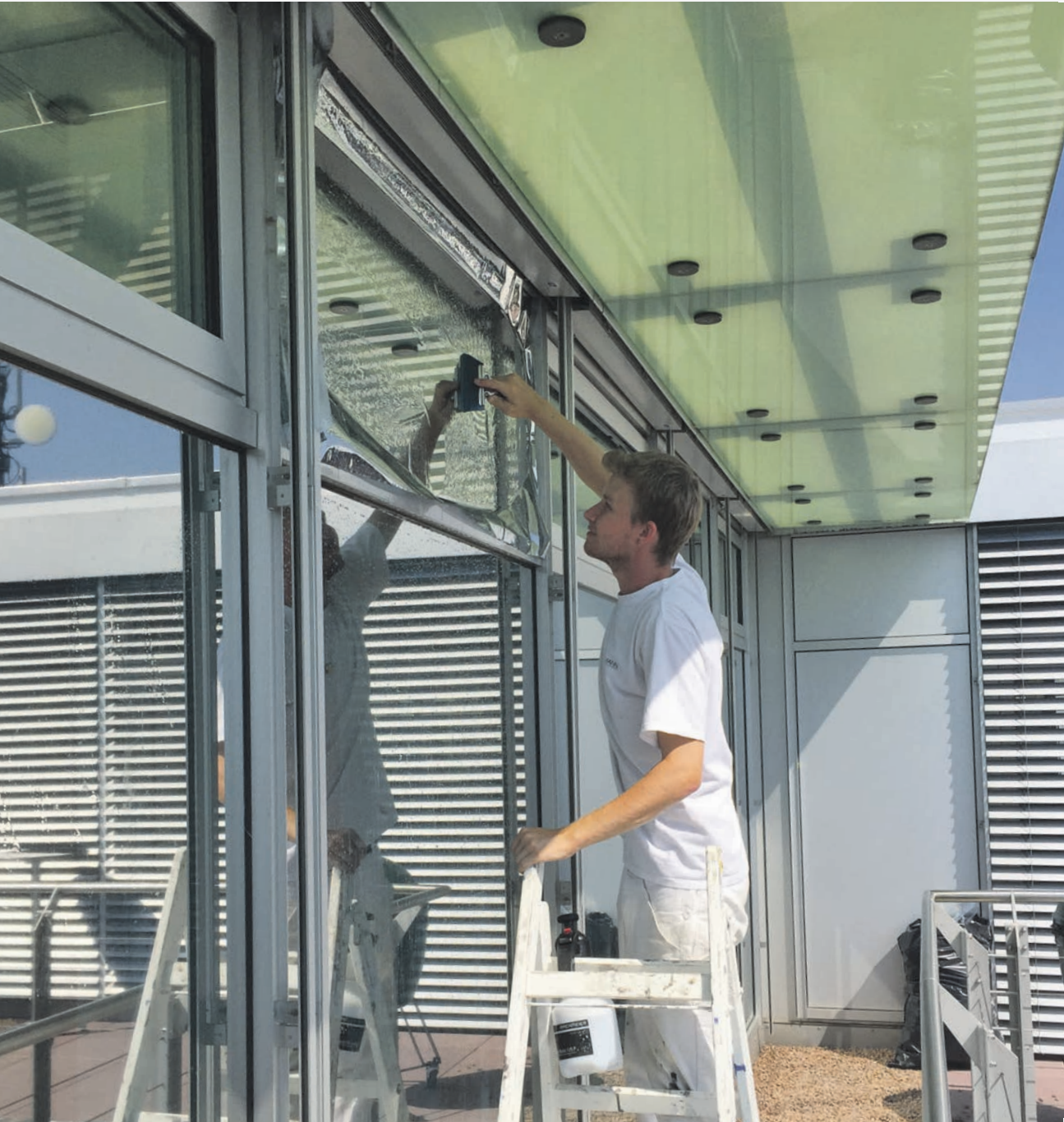
Montage der Fensterfolie
